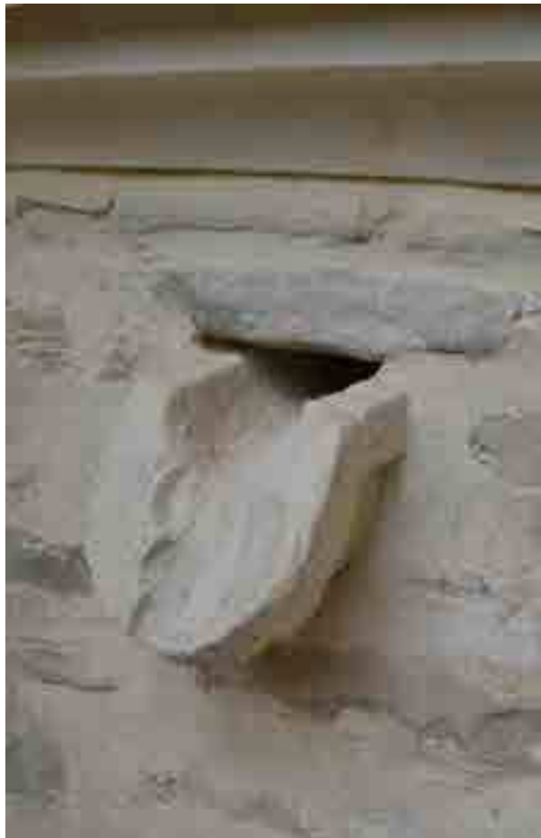
Каменный водосток на крыше церкви.
