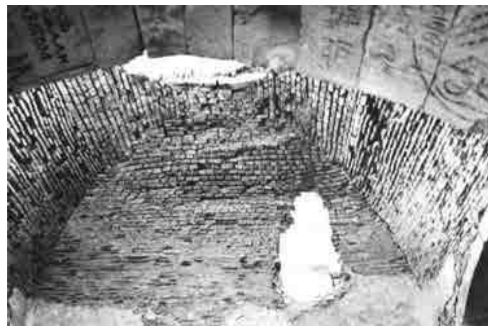
Разрушенный плинфовый свод южного зала трапезной в 1993 году.
