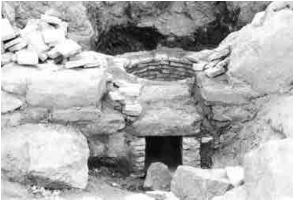
Реставрация дренажного колодца у главного входа в монастырь в 1994 году.
