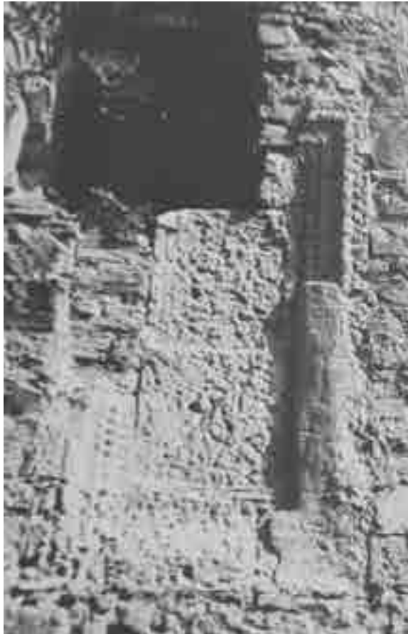
Остатки резной ниши на западном фасаде трапезной. Фото 70-х годов XX века.
