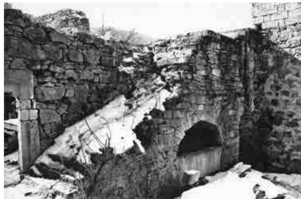
Лестница, ведущая в надстройку. Фото 1992 года.
