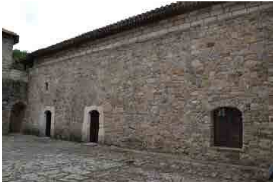
Трапезная. Восточный фасад.
