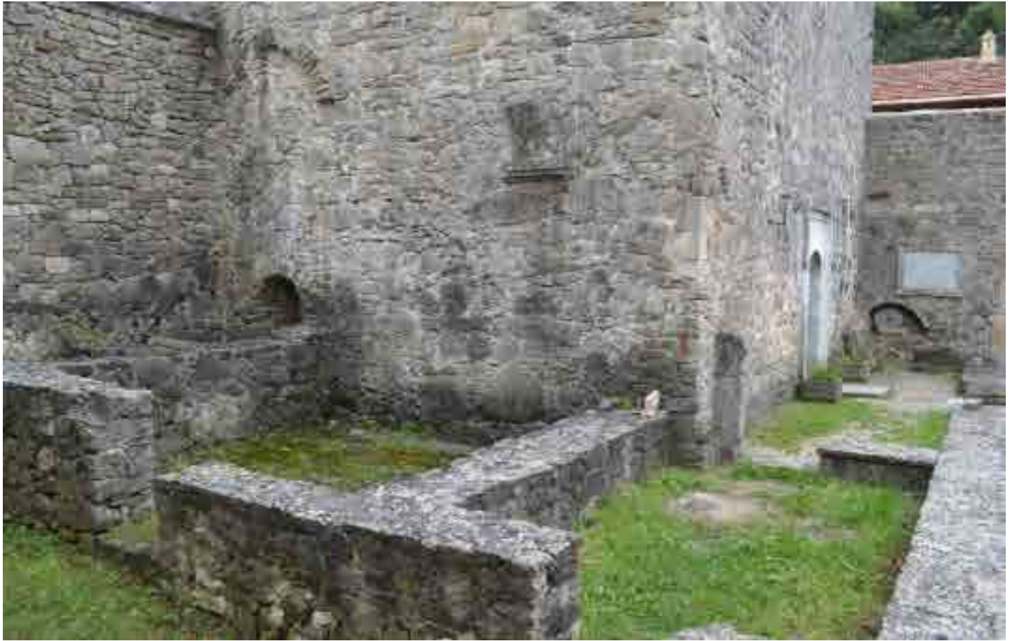
Остатки сооружений севернее гавита.
