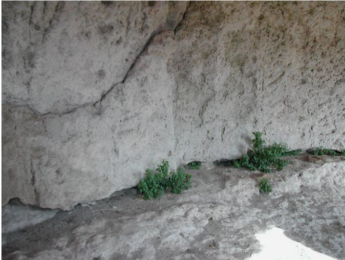
Рис. 3. Часть северной стены пещеры. Видны следы ломки камня и подрубки для крепления стеллажей.
