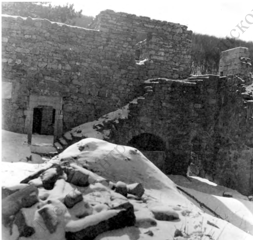
Парадный двор (атриум) до восстановления. Вид на юг. Фото 1992 года.
