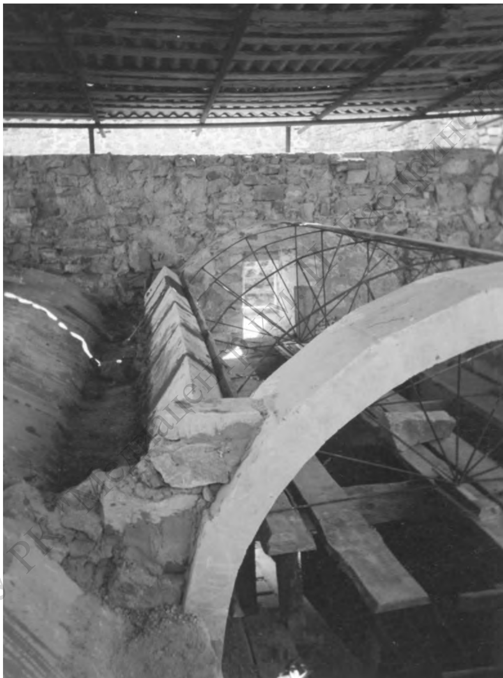
Восстановление сводов в южном зале трапезной в 2000 году.
