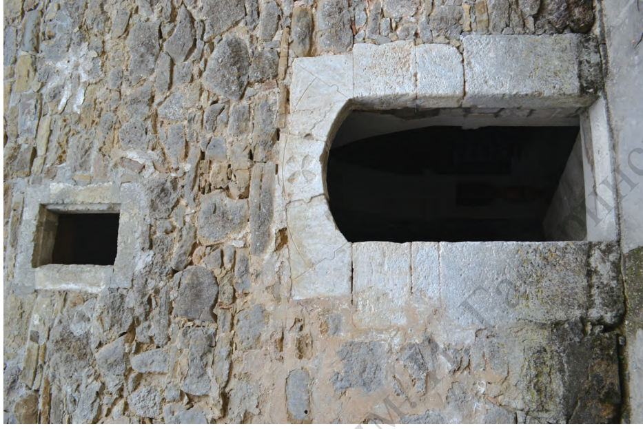
Вход в южный зал трапезной.
