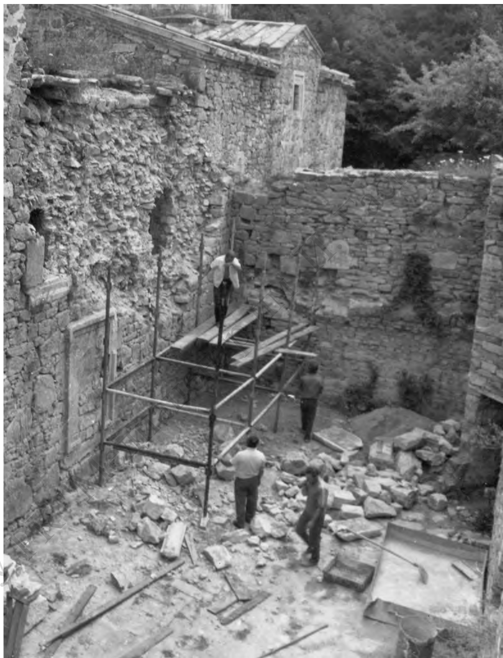
Восстановление южной стены гавита в 1993 году.
