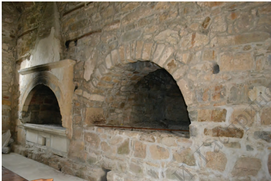
Камин и печь в северном зале трапезной.
