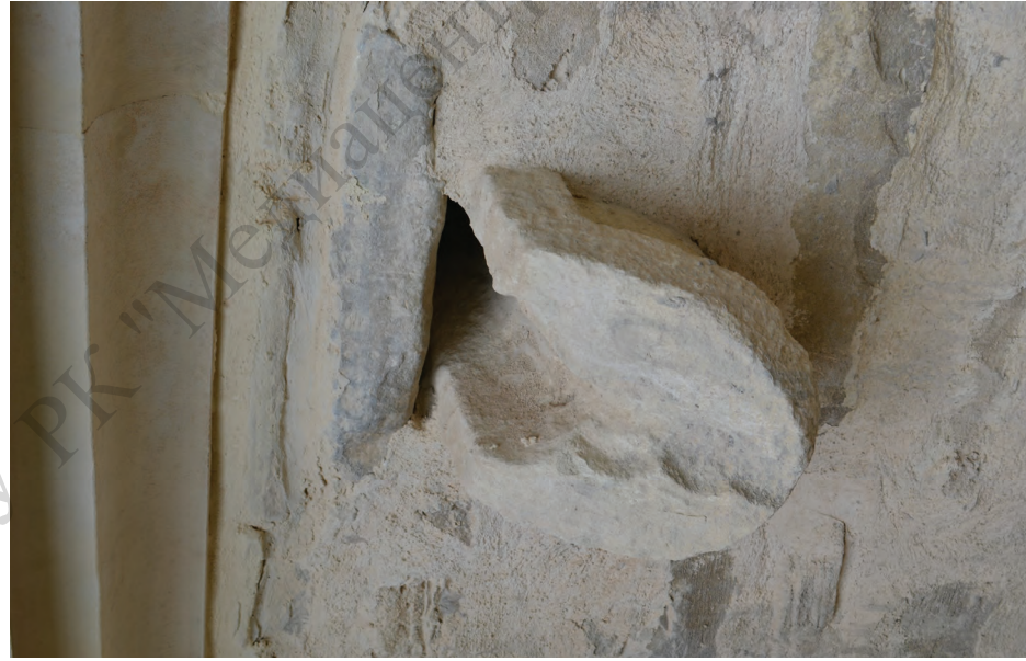
Каменный водосток на крыше церкви.
