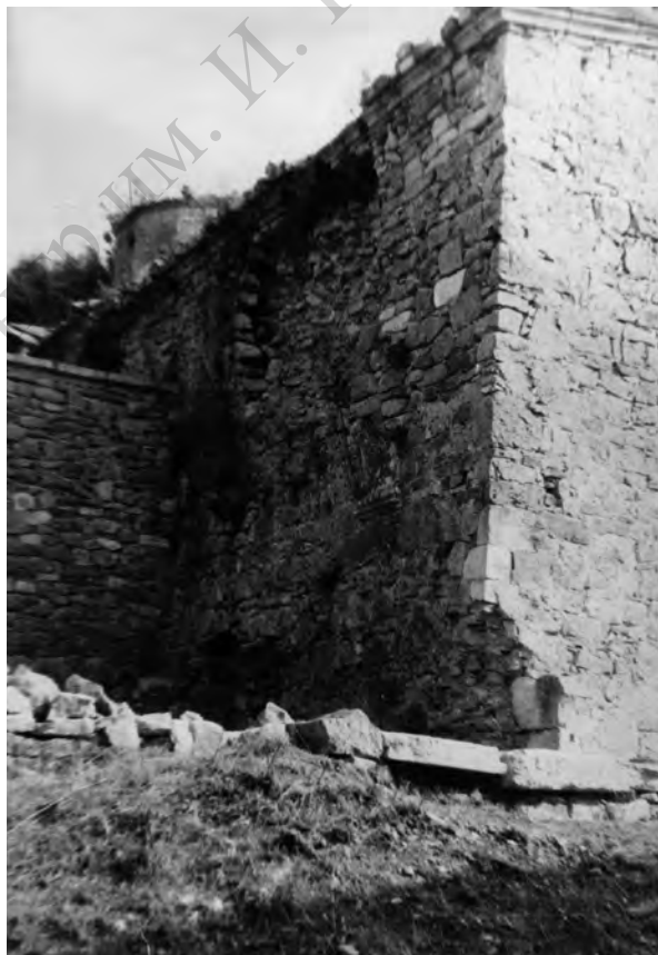
Северная стена гавита до восстановления. Фото 1993 года.
