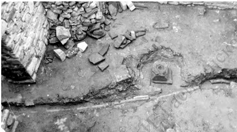
Ветвь водоотвода, проходящая через привратническую. Фото 1993 года.
