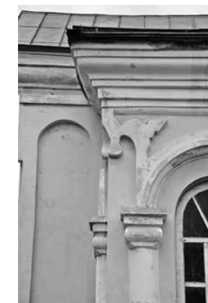
Церковь в селе Крым. Фрагмент оформления фасада. Фото А. Казаряна, 2018
